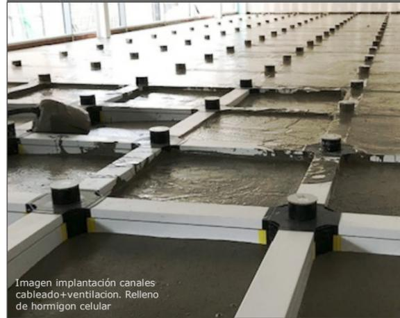
Imagen implantación canales cableado+ventilación. Relleno de hormigón celular
